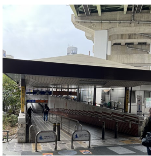
地下通路入口
